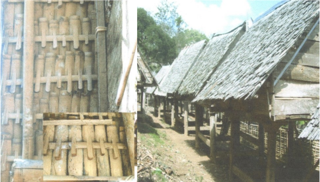
Gambar 2. Santeak atau atap bambu dengan inset detail pemasangan (kiri) dan alang atau lumbang padi (kanan) sebagai bangunan asli masyarakat Samawa
